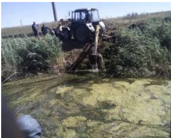
Очистка рибозахисної споруди насосної станції № 1 КРЗС
