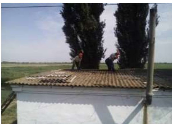
Ремонт покрівлі н/ст «Степова»
