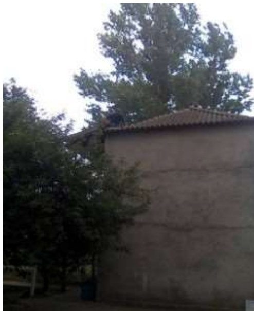
Установка покрівельник коників на побутовому приміщенні н/ст «Кагачінська» КГНС Кагачінської ЗС
