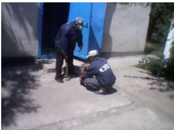
Ремонт засувки в розподільному колодязі площадці н/ст КГВ Шевченково
