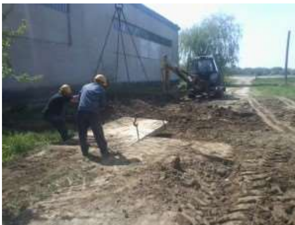
Ремонт дороги до н/ст «Кофа»
