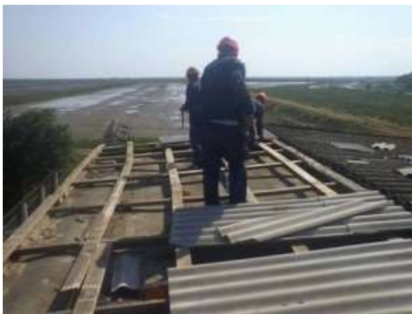
Ремонт покрівлі н/ст «Осушувальна»
