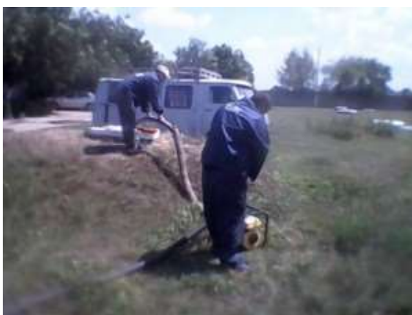
Відкачка води з розподільного колодязя при ремонті засувки
